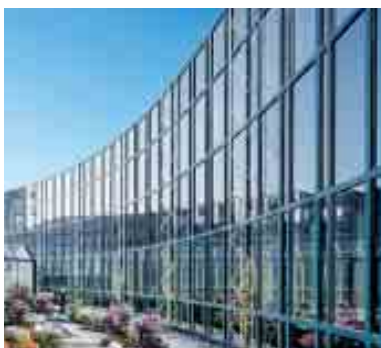
Админ. здание, Эннепеталь, Германия Office building, Ennepetal, Germany
